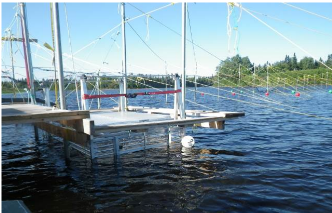
Photo 5 : Cage et haubans
