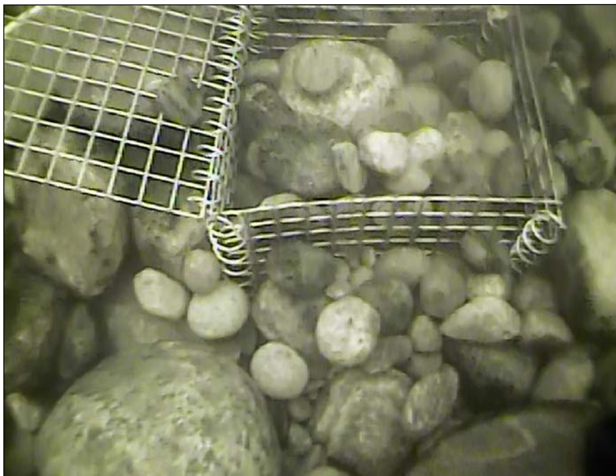
Photo 9 – Implantation d'un dispositif en gabion (frayère aménagée du PK 51)
