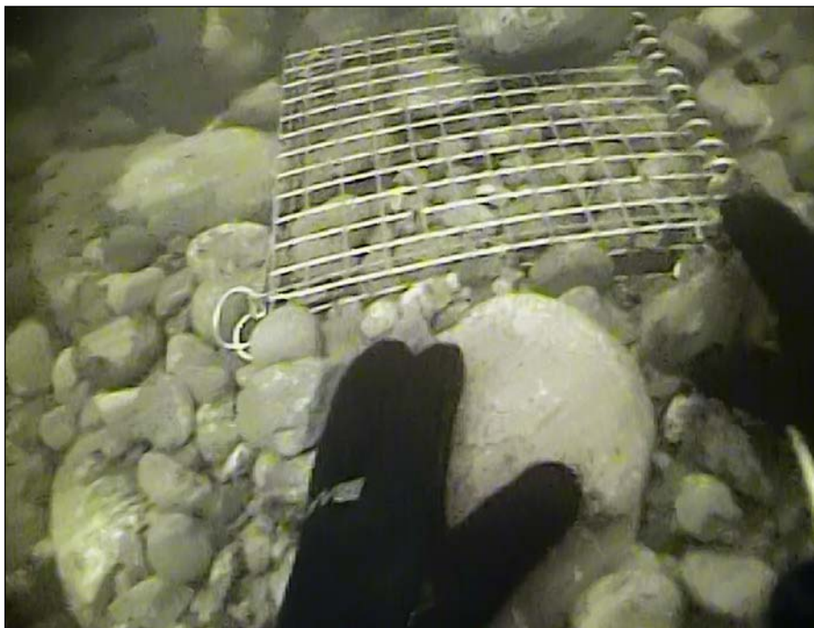
Photo 10 – Implantation d'un dispositif en gabion (frayère aménagée du PK 51)
