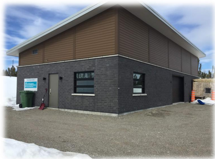
Photo 1. Vue extérieure de la station piscicole mise en service en octobre 2016.
