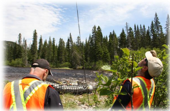
Photo 23. Arrivée des équipements sur le site de travail.
